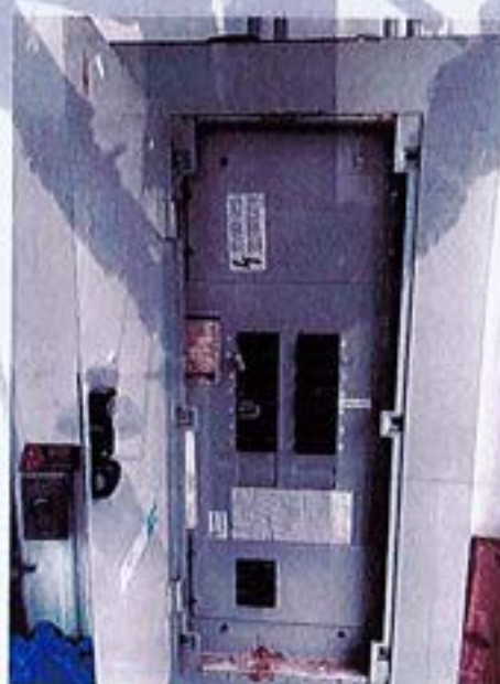
✓ TAB. "CAS1" Alumbrado y Contactos Caseta #1
